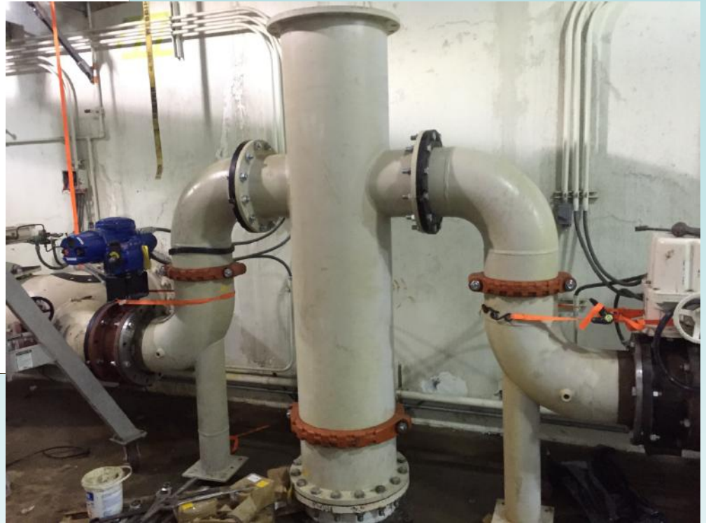
New effluent standpipes
