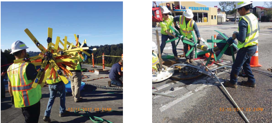
Figure 5. Left - 24D PipeDiver tool. Right – Mini PipeDiver tool.
